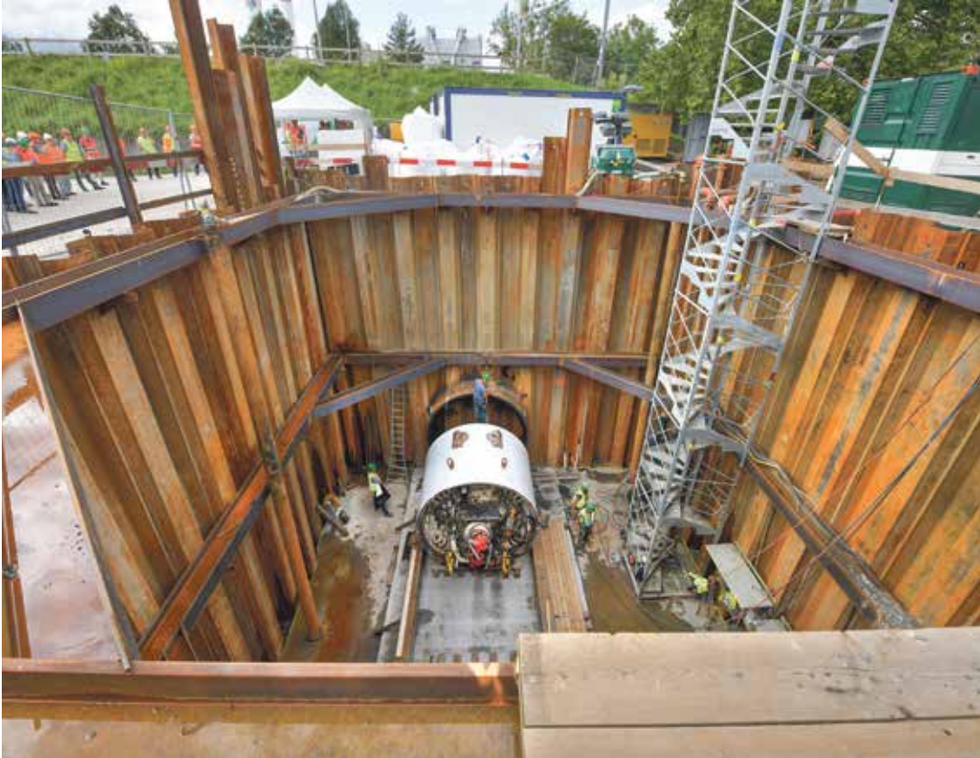
Un tunnelier de 3 m de diamètre creusera le tunnel qui accueillera la conduite reliant Satom à Cimo. | C. Dervy
