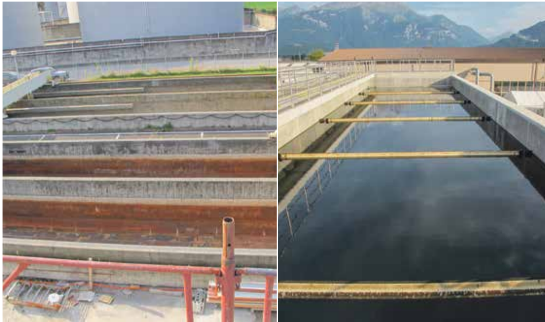
Dans la nouvelle STEP, le deux lignes de bassins ont doublé de volume.
