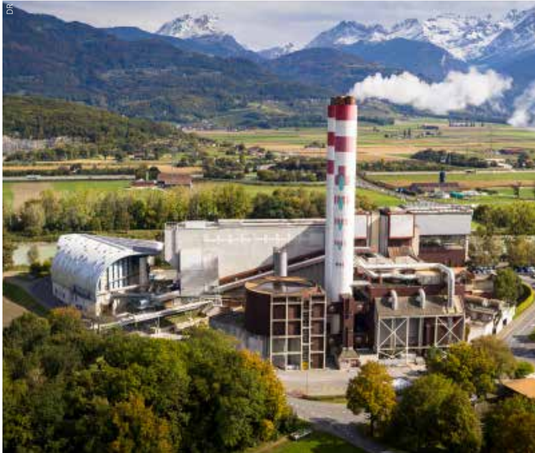
L'entreprise de traitement des déchets, inaugurée en 76, couvre 73 communes valaisannes et vaudoises.
