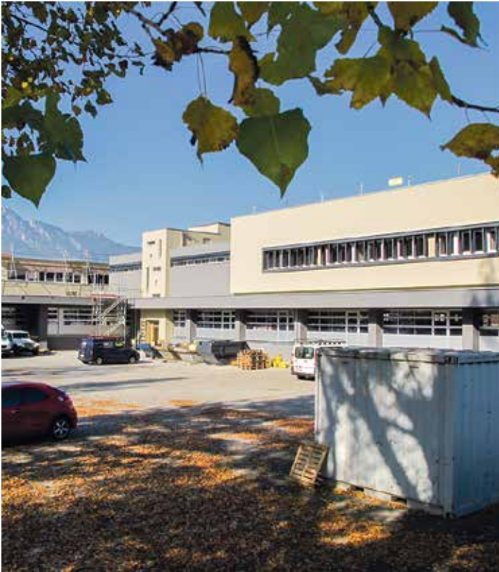
Les aménagements extérieurs devraient être réalisés l'an prochain.
