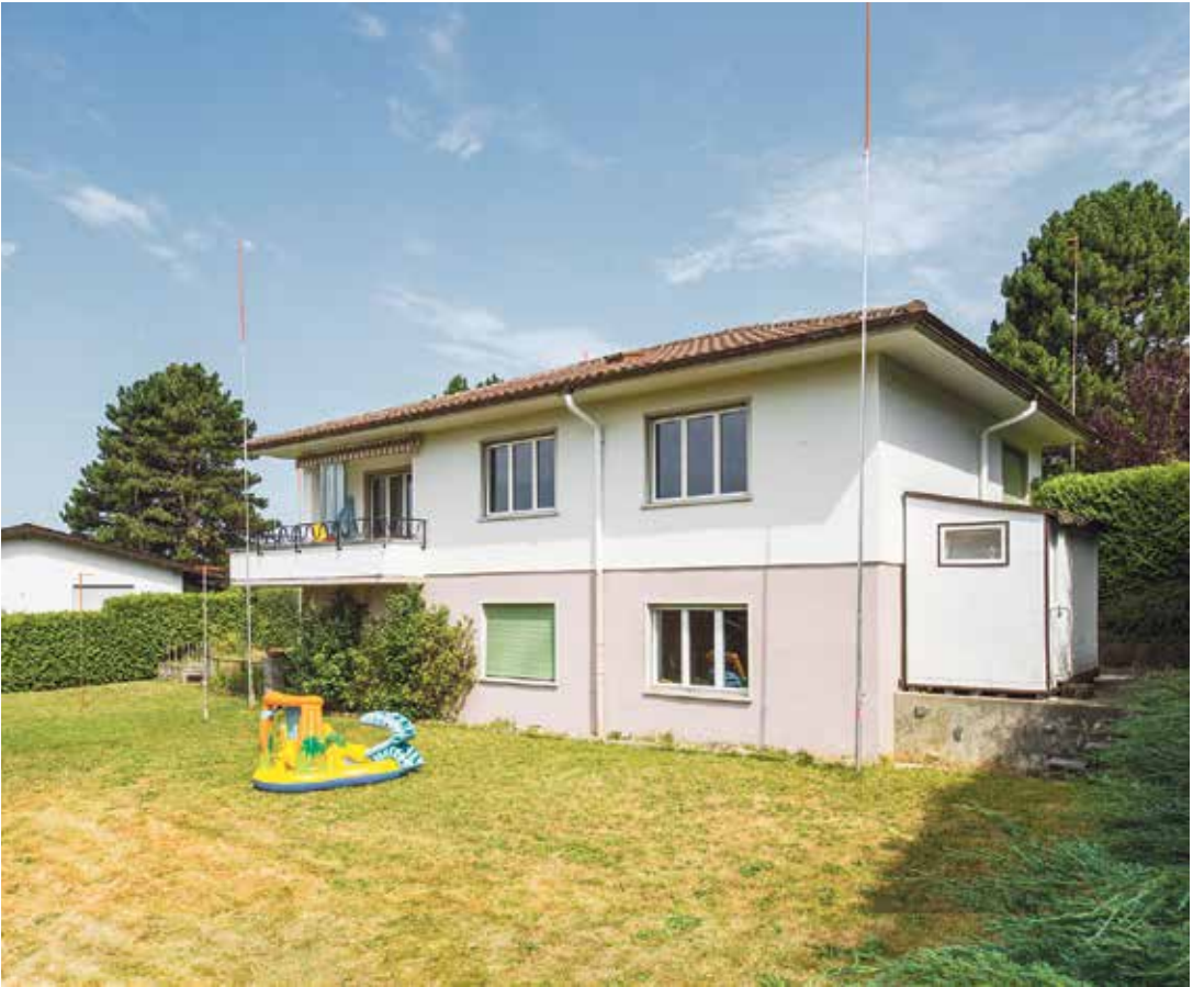
La villa d'origine avant les travaux de rénovation et de surélévation.
