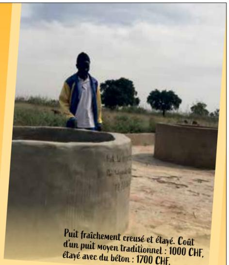
Puits fraîchement creusé et étayé. Coût d'un puits moyen traditionnel : 1000 CHF, étayé avec du béton : 1700 CHF.
