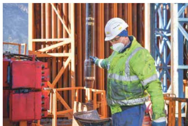
Des tiges de 15 m chacune sont assemblées sur la tour et emmenées par la foreuse dans le sous-sol.
