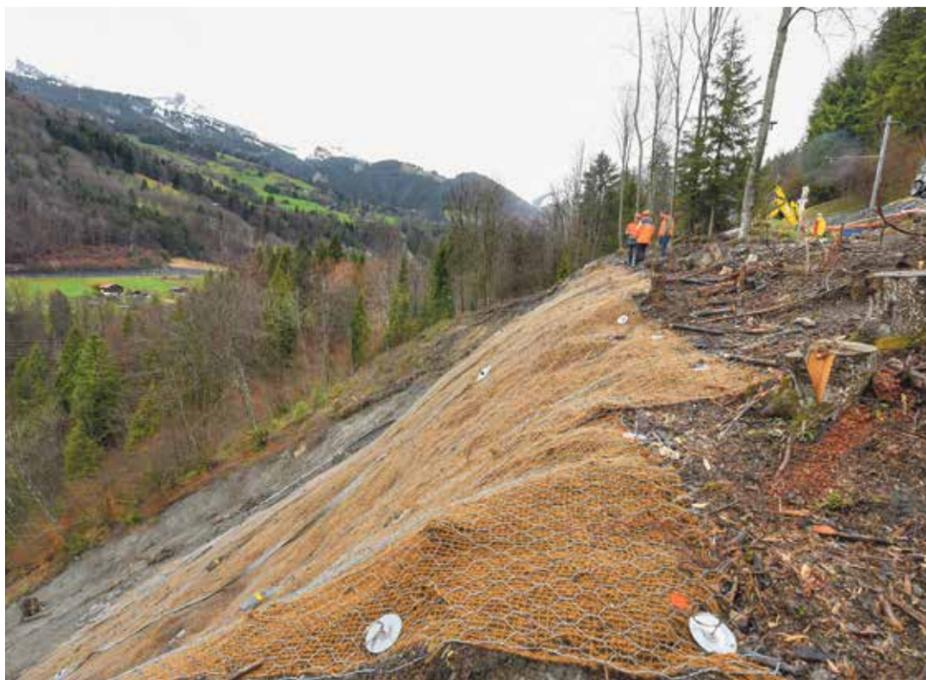
La zone de glissement la plus active se situe en contrebas de la ligne. Des ancrages ont dû être réalisés pour tenter de freiner le mouvement du terrain. | C. Dervev - 24 heures
