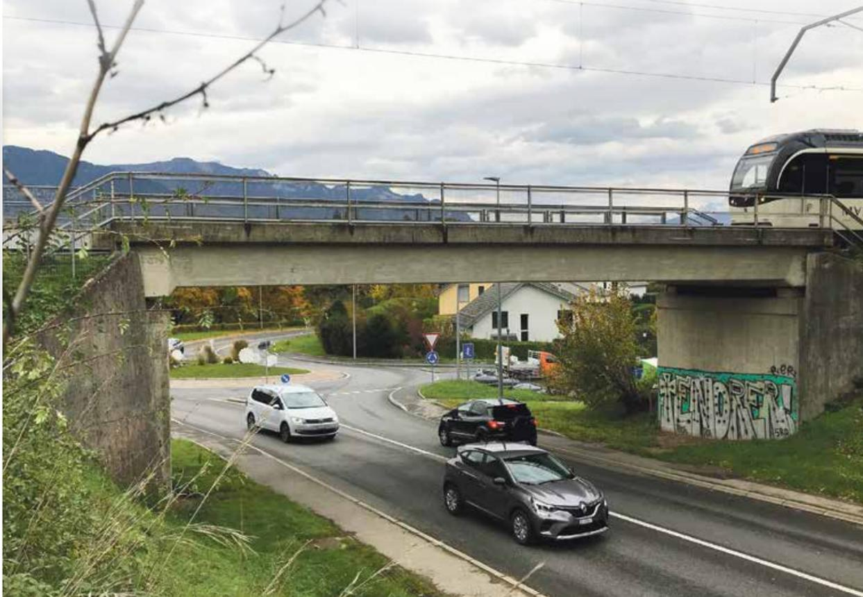
La nouvelle passerelle sera posée parallèlement au pont du MVR, à deux mètres de ce dernier.
