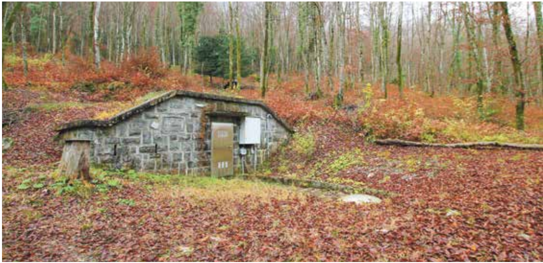
Sur les hauts du Bouveret, la source supérieure, dont on voit ici l'entrée, devrait bientôt être équipée d'une citerne géante de 1'500 mètres cubes.
