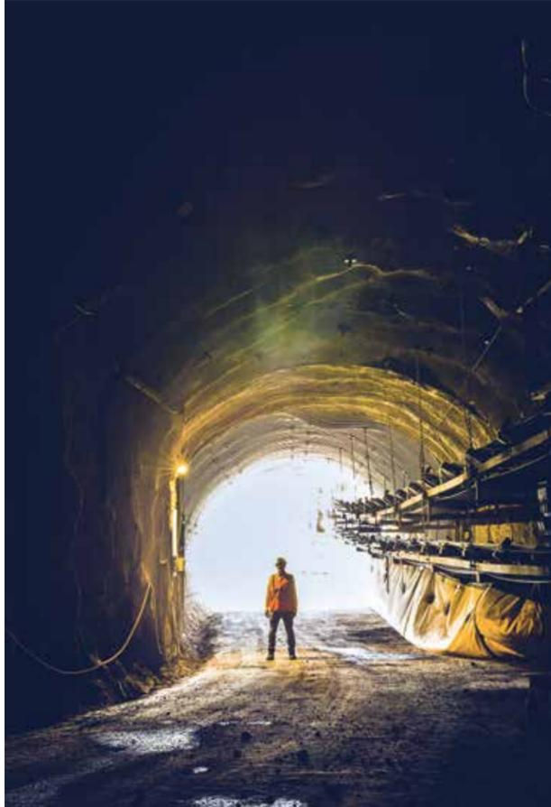
L'entreprise villeneuvoise, une trentaine d'employés, a travaillé dur pour permettre cette nouvelle forme d'extraction souterraine, moins impactante pour l'environnement et la population. Avec notamment la construction d'un tunnel et d'un puits de dévalage des roches. | Carrières d'Arvel SA
