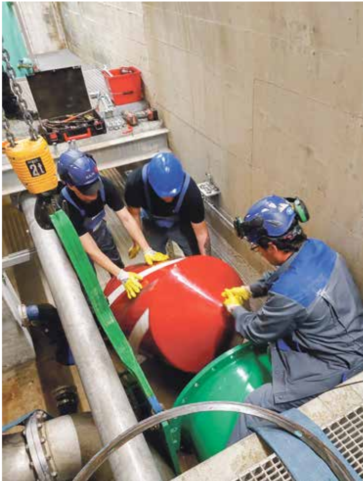
Le nettoyage de ce tuyau en pente se fait grâce à l'introduction d'une sorte d'obus en plastique, poussé par de l'eau sous pression. | SIGE
