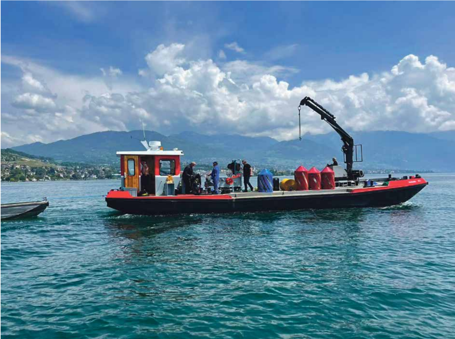
Après avoir parcouru les 300 mètres de la conduite, les outils regagnent la surface où ils sont repêchés par une barge.
