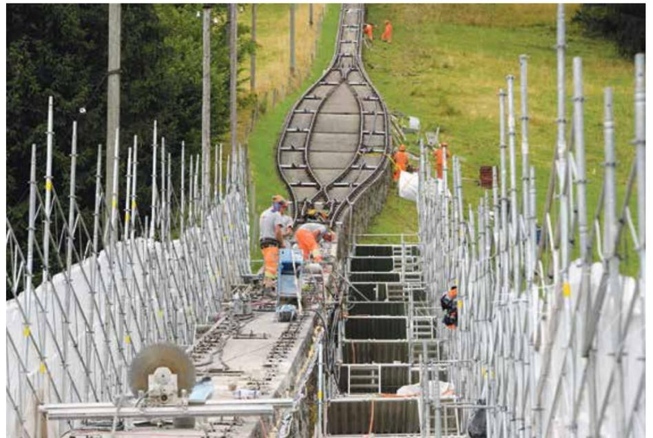
Protégés de chaque côté par des échafaudages, les ouvriers refont la dalle de béton qui recouvre le fameux viaduc. La dernière opération du genre remontait à 1980.
