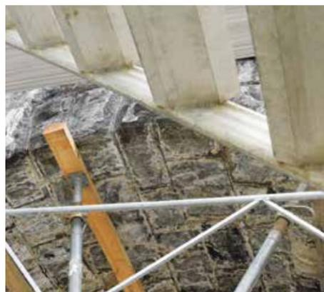
L'assainissement du viaduc et de ses onze arches comportera également une réfection des joints entre les pierres. La construction de l'ouvrage date de 1910.
