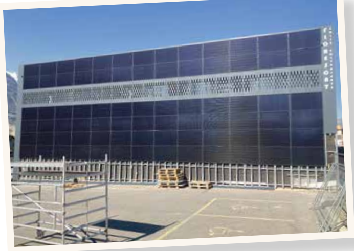
Les panneaux solaires seront intégrés aux parois antibruit, à l'image de ce qui a été réalisé ici sur un bâtiment à Saxon.
